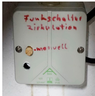
Den links abgebildeten Funkempfänger habe ich in eine Verteilerdose eingebaut
